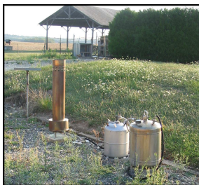
Une station du réseau ADELFA.18 à Civray avec son grêlímètre et son générateur.
